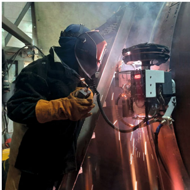
Рис. 6. Общий вид зоны выполнения сварочных работ
